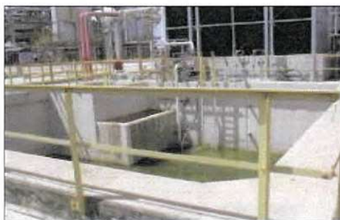
บ่อรวบรวมน้ำเสีย ES-1890 และระบบ Oil Skimmer
